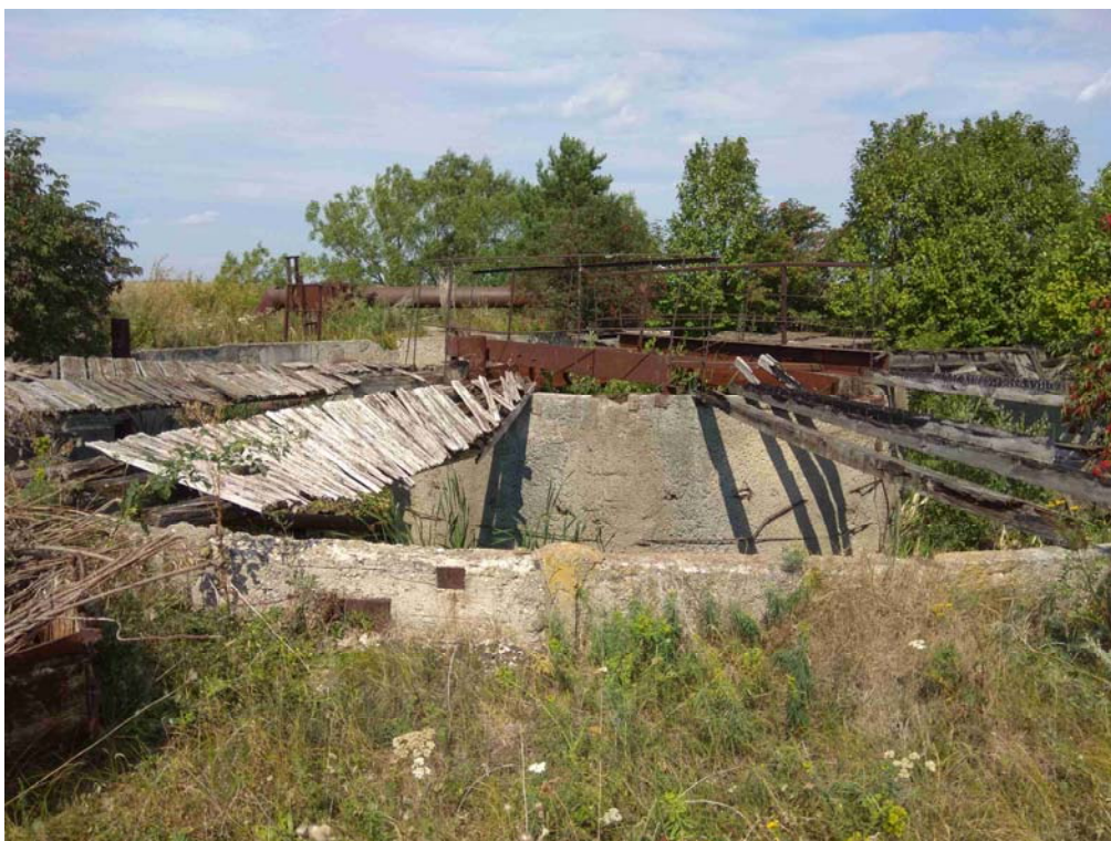
Рисунок 9.3. ОСК Торбеевского городского поселения. Радиальный отстойник, не в рабочем состоянии.
