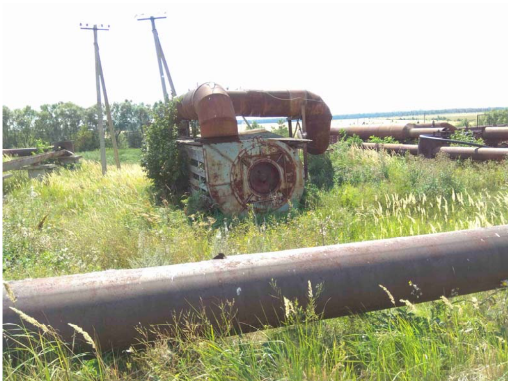
Рисунок 9.5. ОСК Торбеевского городского поселения. Заброшенные агрегаты воздуходувной станции.
