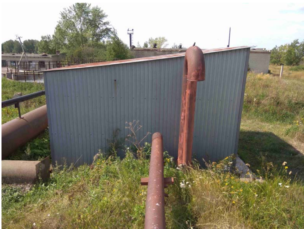
Рисунок 9.6. ОСК Торбеевского городского поселения. Павильон рабочей компрессорной для воздуходооборудования аэротенков.
