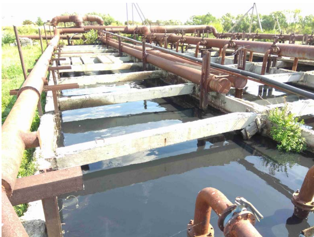
Рисунок 9.4. ОСК Торбеевского городского поселения. Аэротенк (на момент съемки, без аэрации сточных вод).
